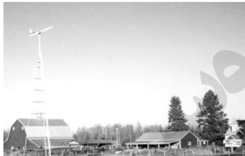
در ناحیه دره کلاور در منطقه مینوستا، یک توربین سه کیلووات با نام اچ175 ویسپر در یک برج 500 فوتی به شبکه خدمات متصل شده است تا برق مورد نیاز منطقه را تامین کند.
