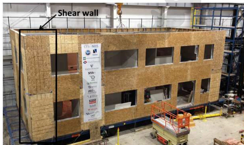
شکل 1: ساختمان CFS-NEES و دیوار برشی در داخل آن
